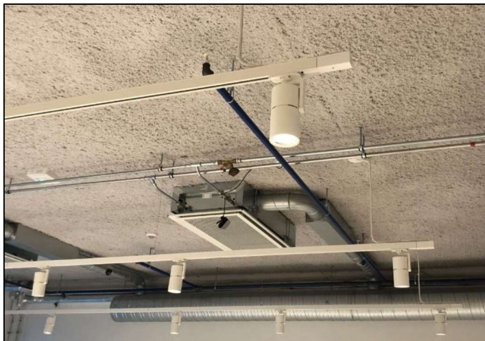
Påføring av cellulosespray og ferdig himling. Foto: Rune Andersen
