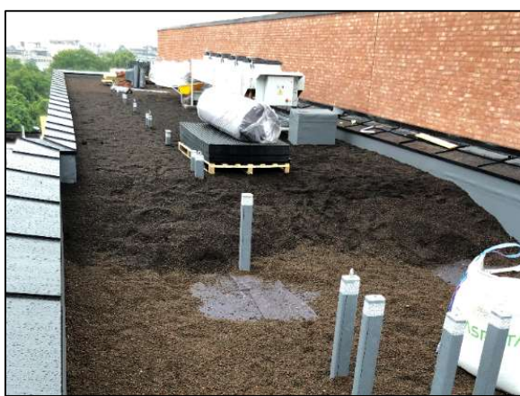
Gjenbruksjord legges på taket. Foto: Rune Andersen
