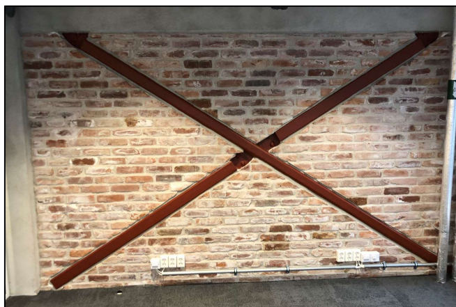
Oppmuring og ferdig brannvegg. Foto: Rune Andersen
