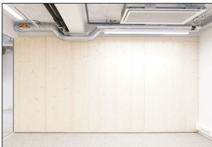
Ferdig vegg. Foto: Kyrre Sundal
