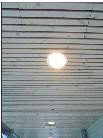
Trespiler demontert fra himling i korridor på Refstad skole. Foto: Anne S Nordby Lagring og produksjon hos LUN. Foto: Lars Ulrich Nielson Montering i KA13. Eksisterende skruehull beholdt. Foto: Kristine Aassved Storeide
