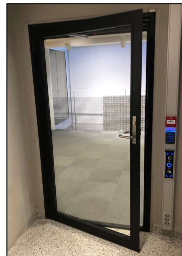
1-2: Dørfelt fra DEG8, overliggende glassfelt fjernet og dør montert i KA13 med ny låssylinder. Foto: Anne S Nordby 3: Brukt brannndør, ferdig montert og lakkert. Foto: Rune Andersen
