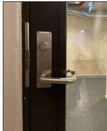
Klasseromsdører, Refstad skole. Foto: Anne S Nordby Brukte håndvridere/skilt fra Refstad montert på nye branndører i 2-8 etg. (vestsiden av trapperom). Foto: Annethe Thorsrud
