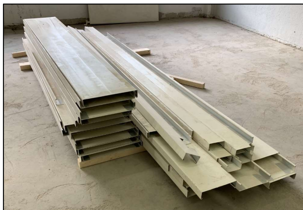
Kabelbaner etter demontering. Foto: Randi Lunke
