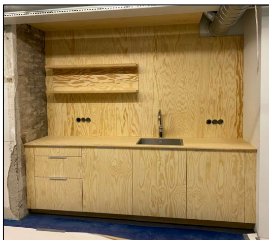
Skrog ferdig montert med nye fronter i 15 mm kryssfiner. Foto: Lars Ulrich Nielson/LUN og Anne S Nordby
