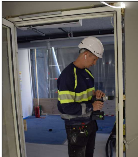
1-2: Dørfelt fra DEG8, overliggende glassfelt fjernet og dør montert i KA13 med ny låssylinder. Foto: Anne S Nordby 3: Brukt brannndør, ferdig montert og lakkert. Foto: Rune Andersen
