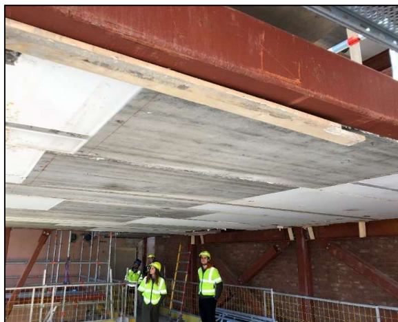
Underside ferdig dekke, brukte elementer. Foto: Rune Andersen
